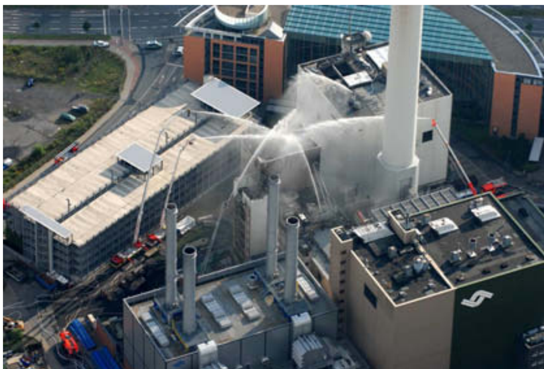
24.08.2006 Feuer in der Rauchgasentschwefelungsanlage des Kraftwerkes der Stadtwerke Münster Luftbild: Norbert Piontek
