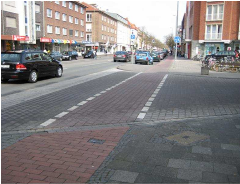
Bild 3: Markierung und Roteinfärbung der Radfurten in Einmündungen
