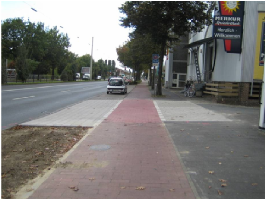
Bild 2: Verdeutlichung der Einfahrten durch Rotpflaster und Markierung
