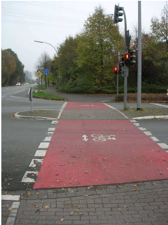
Bild 5: Roteinfärbung und Richtungspfeile in Furten mit Freigabe des Radverkehrs in beiden Fahrrichtungen
