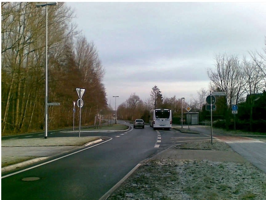
Der Bus hält in der Bucht – das Heck ragt in den Straßenraum
