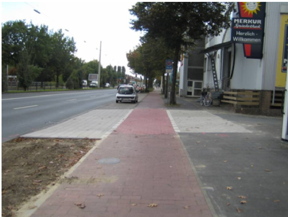
Bild 2: Verdeutlichung der Einfahrten durch Rotpflaster und Markierung
