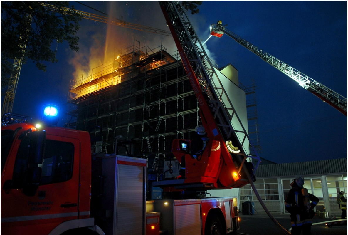
03.05.2009 Feuer in einem Wohn- und Geschäftshaus an der Friedrich-Ebert-Straße Foto: MZ, Helmut Etzkorn
