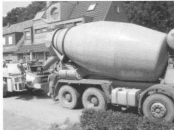
Neubau Brentanoweg 32 im Jahre 2003
