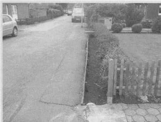
Aktueller Straßenzustand Bild 1 von 5
