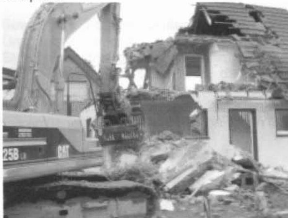
Abriss und Neubau Brentanoweg 36 im Jahre 2002
