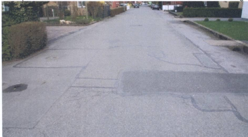
Dasselbe Bild mit Markierung der Flickstellen
