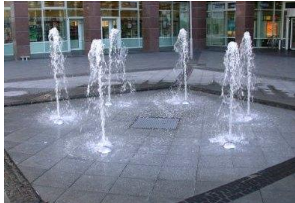
Beispiel für eine mögliche Anlage
