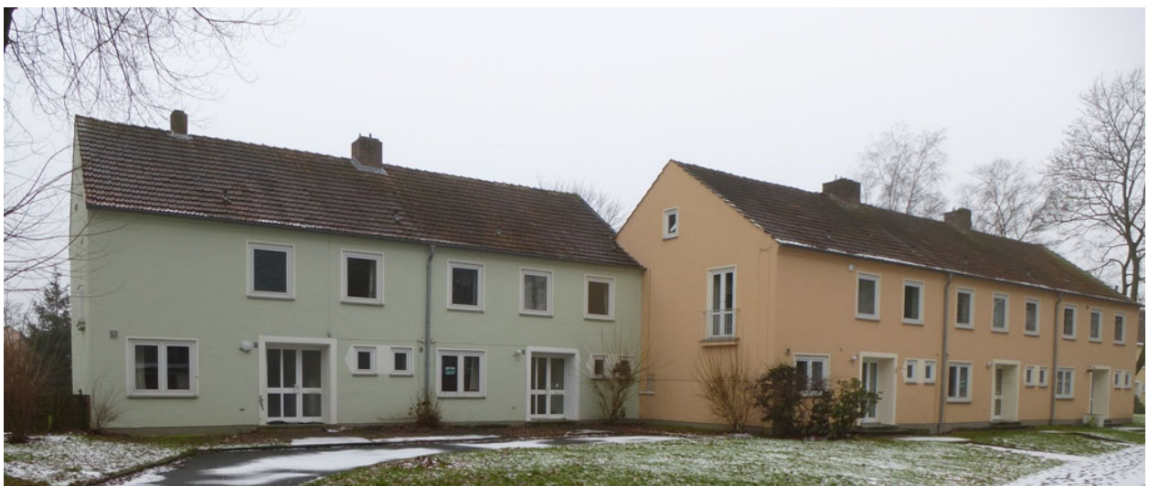
Abbildung 8: Dach und Fassade
