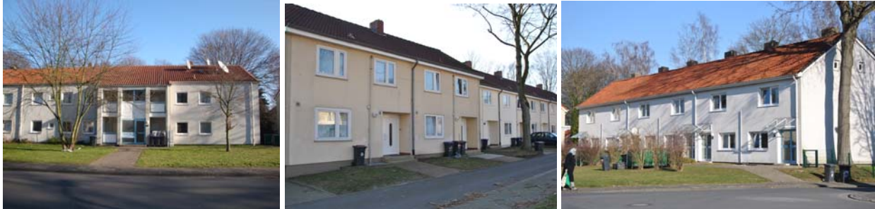
Abbildung 9: Prägende zweigeschossige Bebauung
