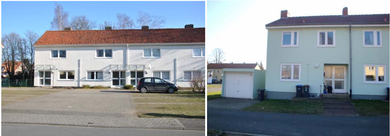
Abbildung 11: Vorhandene Stellplätze aus Rasengitterstein und vorhandene Garage
