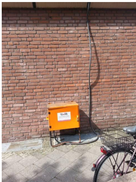
Bild 2 (provisorischer Stromkasten)
