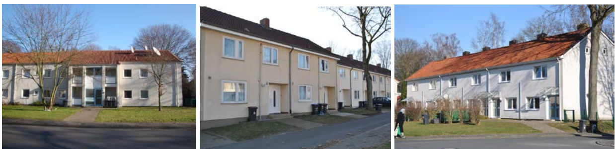
Abbildung 9: Prägende zweigeschossige Bebauung
