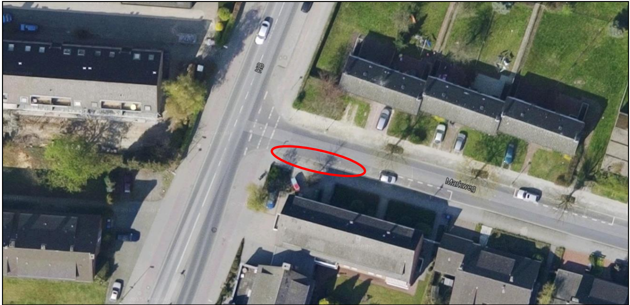
Abbildung 10: Einmündungsbereich Hoher Heckenweg/Markweg
