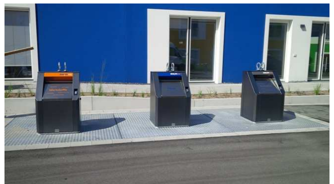
Abbildung 6: Abfallsammlung mit Unterflurcontainern an einem Studentenwohnheim
