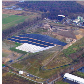
Abbildung 26: Blick in den 3. Bauabschnitt (Stand 2005)
