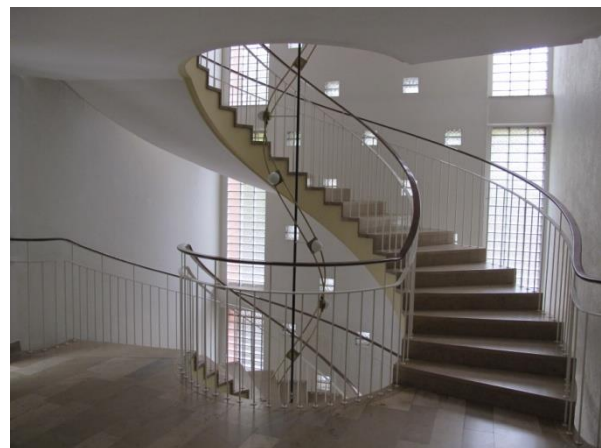
Bauteil C, Treppe zum 2. OG
