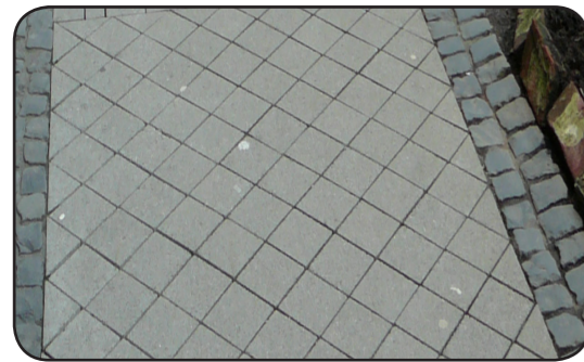
Beispiel Verlegeart Gehwegplatten
