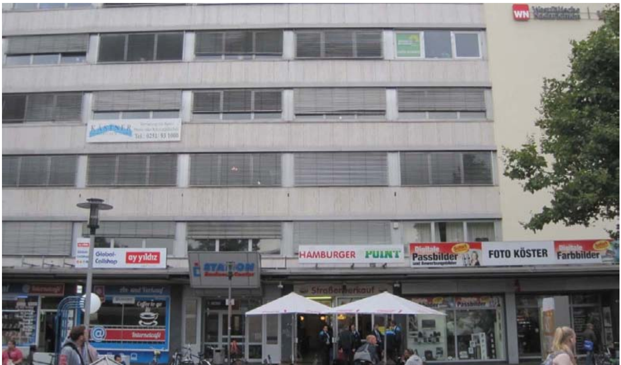
Beispielhafter Fassadenausschnitt „Berliner Platz“ mit ungeordneter und ungestalteter Erdgeschosszone, unstrukturierter Werbeanlagenvielfalt, sanierungsbedürftiger Vordachkonstruktion, instandhaltungs- und sanierungsbedürftiger Obergeschossfassade
