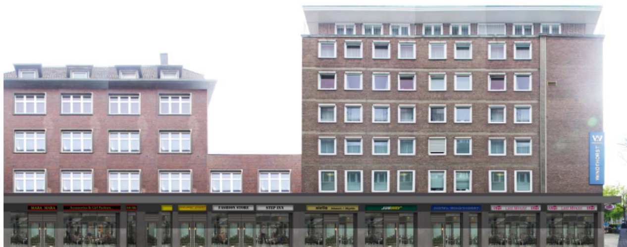
Beispielhafter Fassadenausschnitt „Windthorststraße Süd“ mit geordneter und gestalteter Erdgeschosszone, strukturierter Werbeanlage und einheitlicher Vordachkonstruktion
