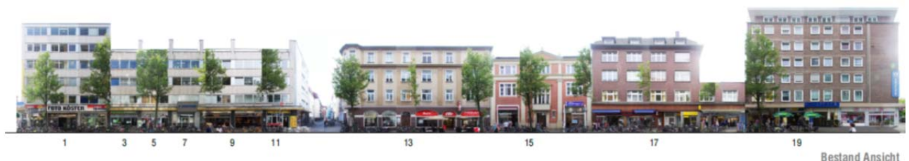
Windthorststraße Süd als Fotomontage mit ungeordneten Werbeanlagen und Baustrukturen
