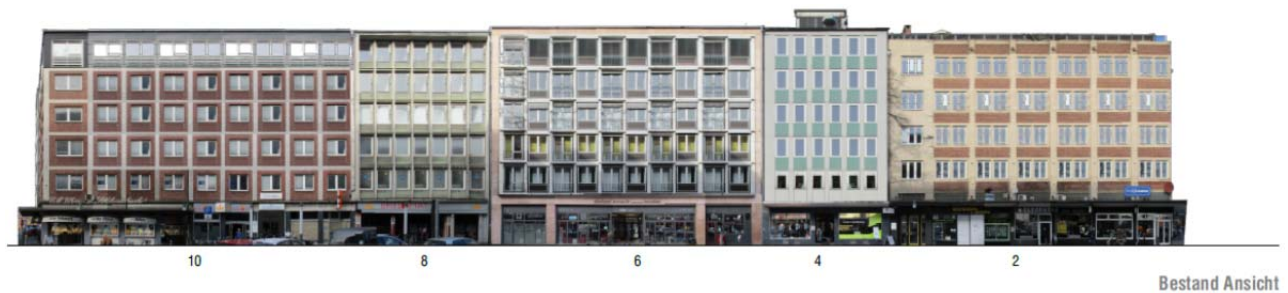
Bahnhofstraße West 2 als Fotomontage mit teilweise ungeordneten Werbeanlagen und Baustrukturen
