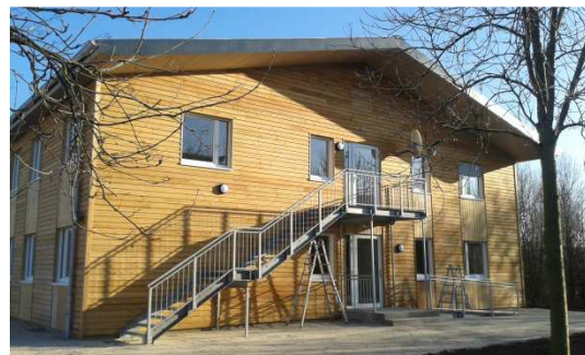
Einrichtung in Holzrahmenbauweise; Foto: Stadt Münster, Amt für Immobilienmanagement
