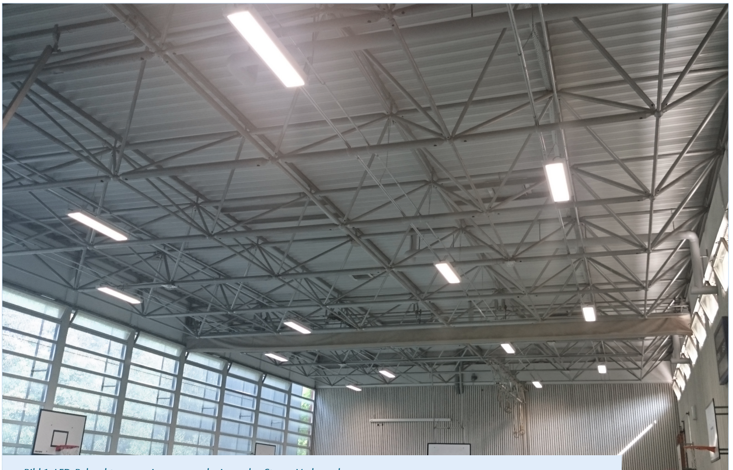
Bild 1: LED-Beleuchtungssanierungen reduzieren den Strom-Verbrauch
