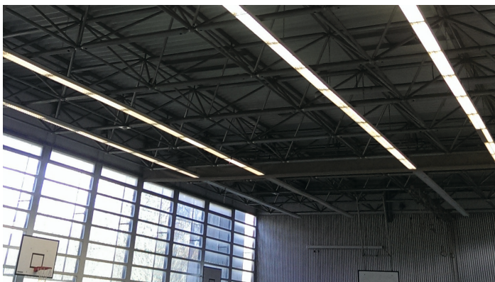
Bild 3: Beispiel für einen Austausch von Leuchtstoffröhren durch LED-Leuchtmittel
