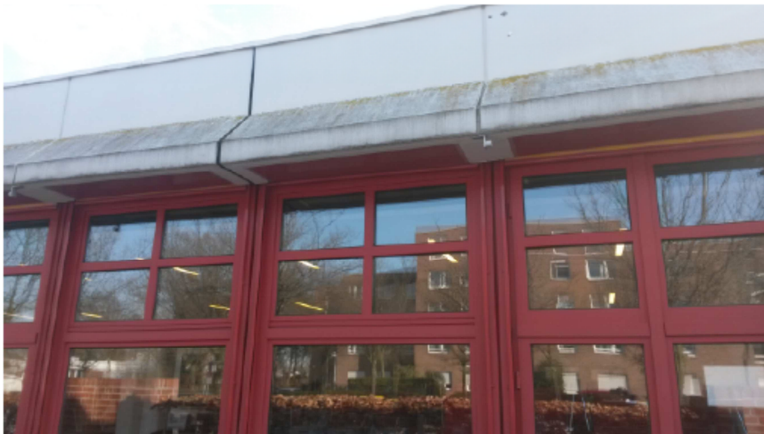
Westansicht Schwachstelle Jalousienkästen und Fensterelemente
