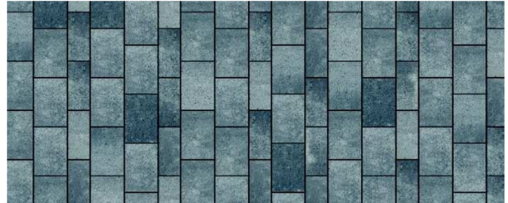
Läuferverband 1/3-Versatz
