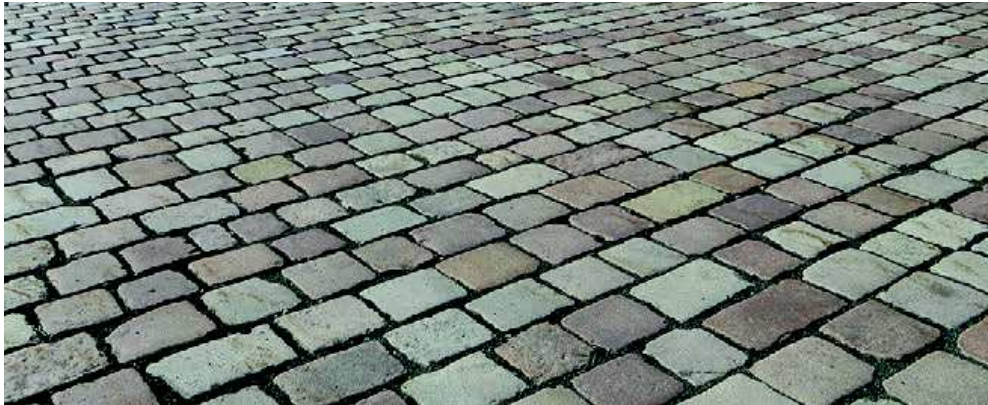
Klein- und Großsteinpflaster
