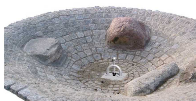
Beispiel Wasserventil in Mulde
