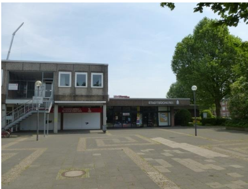
Ist-Zustand Hamannplatz in Richtung Osten (Bild: Stadt Münster, 2019)
