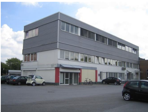
Derzeitige Situation am Gewerbegebiet Kiesekampweg mit Eingang zur Kinderarztpraxis (Bilder: Stadt Münster)
