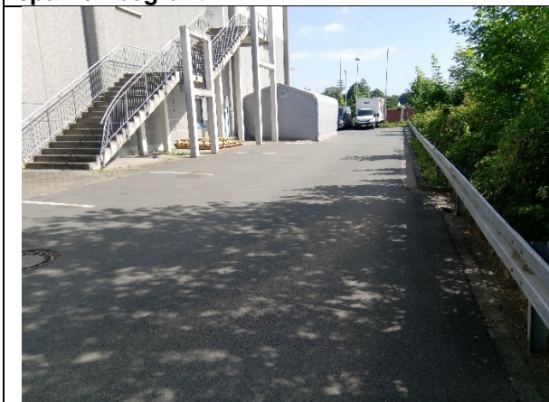
Bild 3: Südseite mit vollversiegelter Umfahrt
