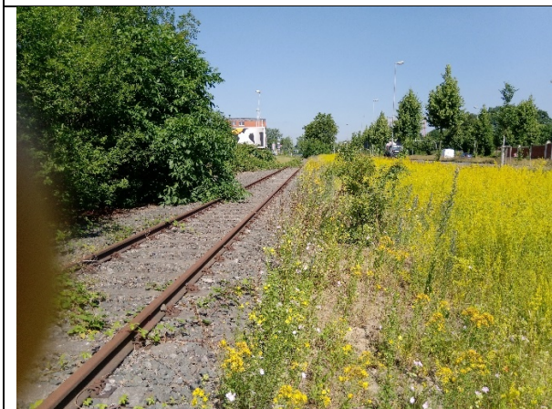
Bild 9: Gleisbett westlich des Albersloher Weges mit begleitender Ruderalvegetation
