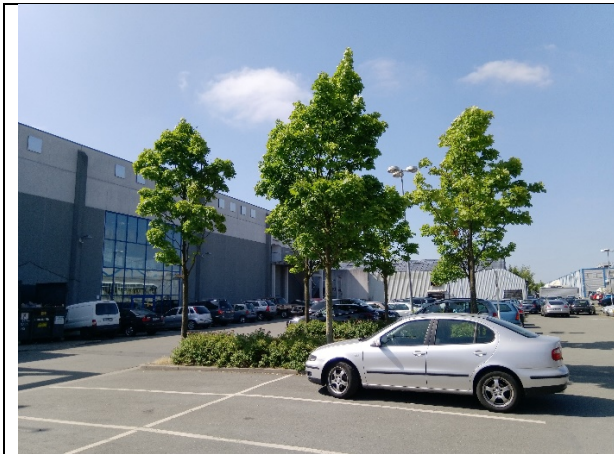
Bild 1: Nordseite, Gebäudefront mit Parkplatz, spärlich begrünt
