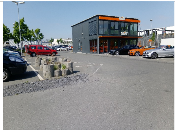
Bild 2: Nordseite, Parkplatz mit Sixt-Pavillon
