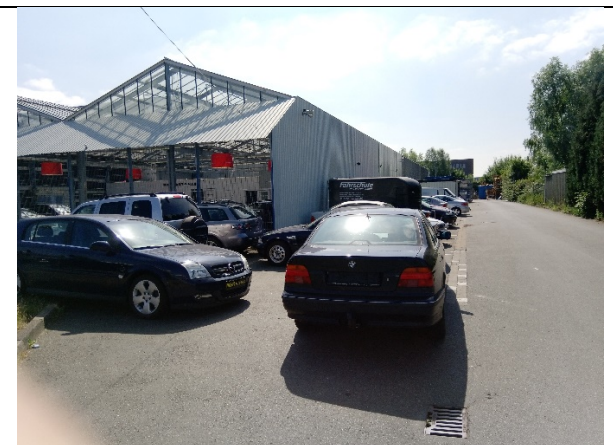
Bild 4: Westseite mit Glasdachgebäude und vollversiegelter Umfahrt
