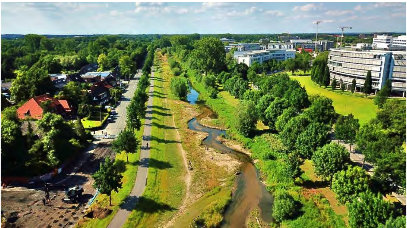
ABBILDUNG 3: RENATURIERTER ABSCHNITT DER MÜNSTERSCHEN AA IM INNENSTADTBEREICH / KANALSTRASSE
