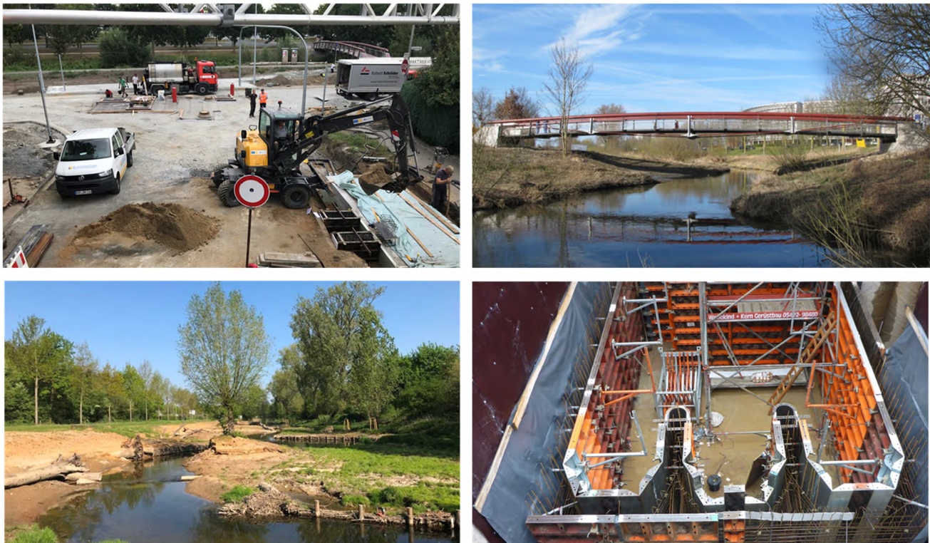
ABBILDUNG 16: BAUMAßNAHMEN AN DER KANALSTRASSE INFOLGE DES STARKREGENEREIGNISSES 2014
