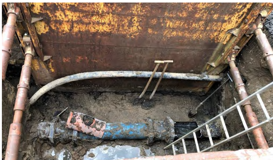
ABBILDUNG 29: SCHADHAFTE DRUCKROHRLEITUNG
