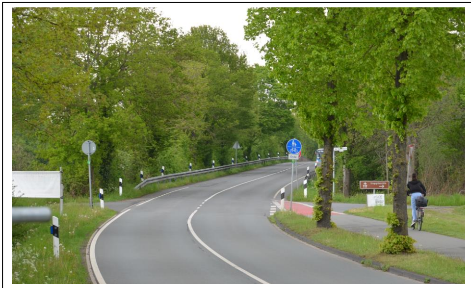
Fahradfahrer vor Überquerung der Brücke / Am „Am Gievenbach“ endet der Fahrrad- und Fußgängerweg
