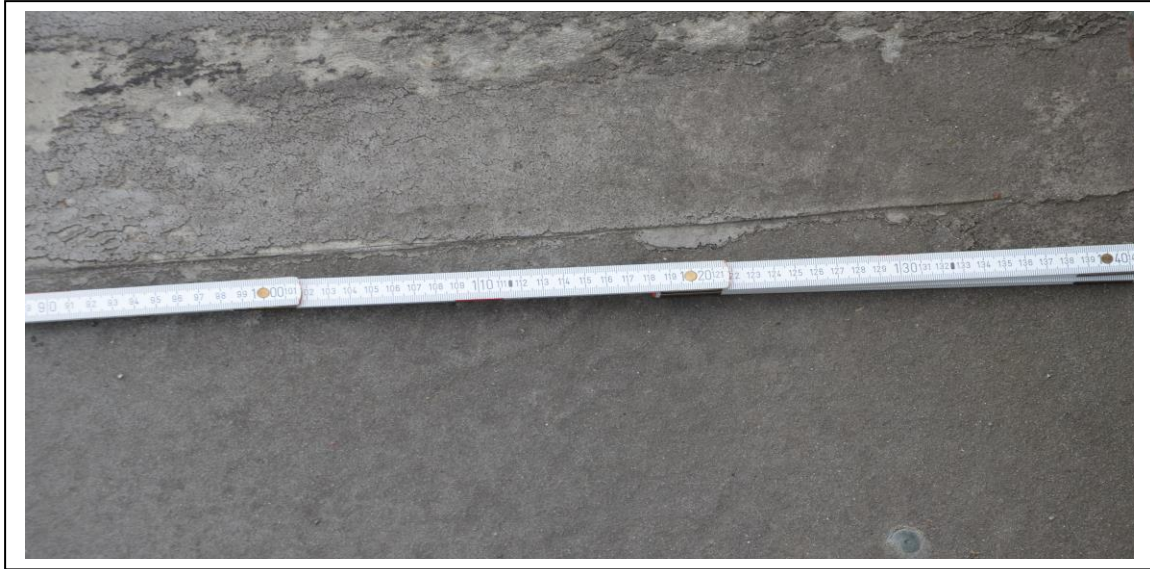
Breite des Fußgängerweges auf der Brücke: 140 cm
