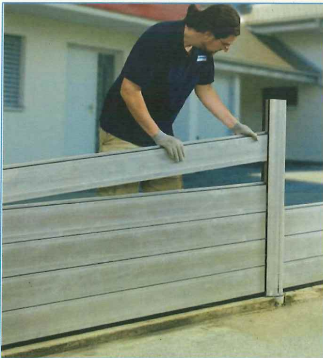
Beispielbild - manuelle Einbringung von Hochwasserschutz-Dammbalken
