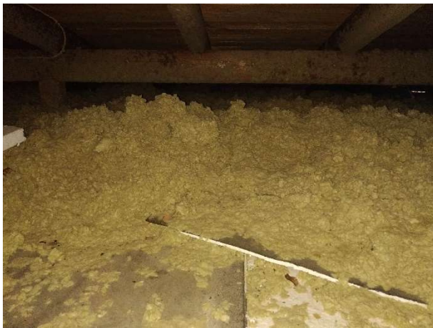
Abbildung 5 Dämmung oberste Geschossdecke Klassentrakt
