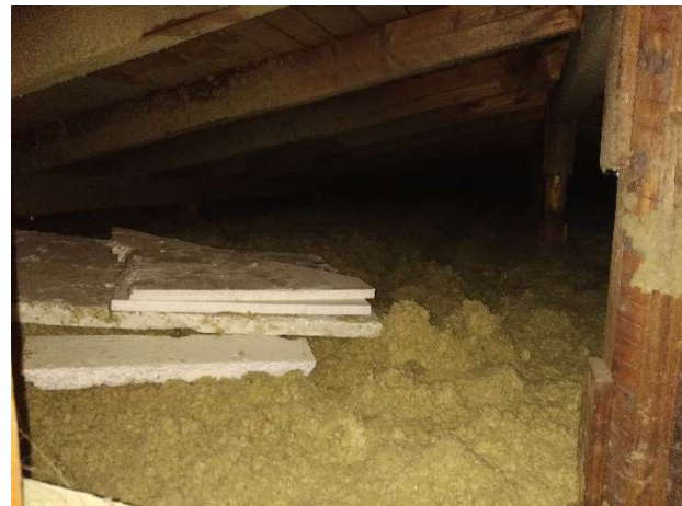
Abbildung 6 Dämmung oberste Geschossdecke Klassentrakt
