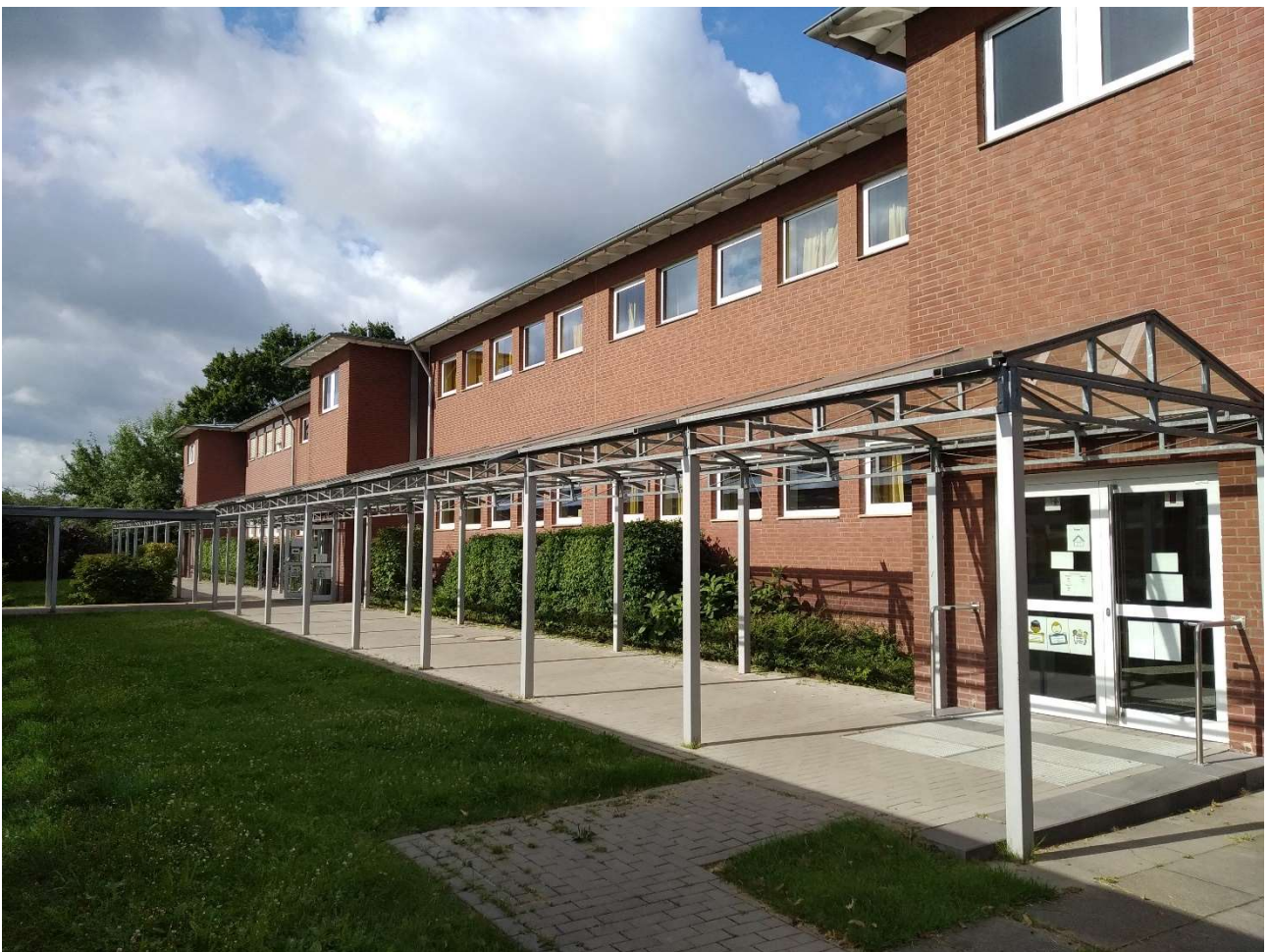
Abbildung 2 Ostansicht Klassentrakt, Anbau im Hintergrund
