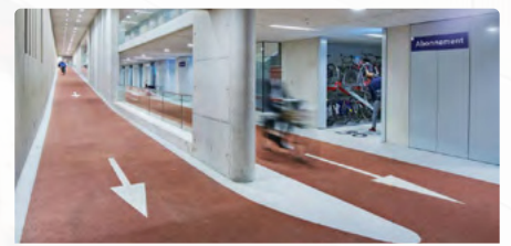
Ganz relaxed – Eine separate Rampe mit geringer Steigung soll die Fahrradparkebenen verbinden. Das ist für Radler nicht nur bequem, sondern auch sicher, da sie getrennt vom Kfz-Verkehr geführt wird.
