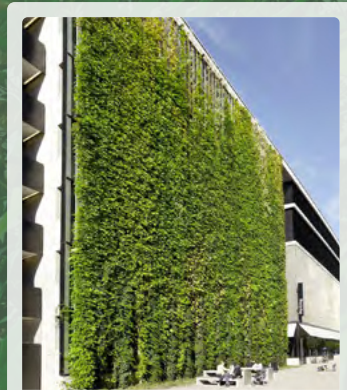
Klimafreundlich und Grün – Flachdach und Fassaden werden begrünt und ressourcenschonend mit Regenwasser gegossen. Davon profitieren Anwohner und Stadtklima.
