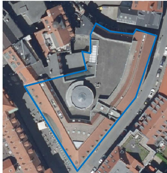
Abbildung 1 Paul-Gerhard-Schule ehem. Clemensschule
