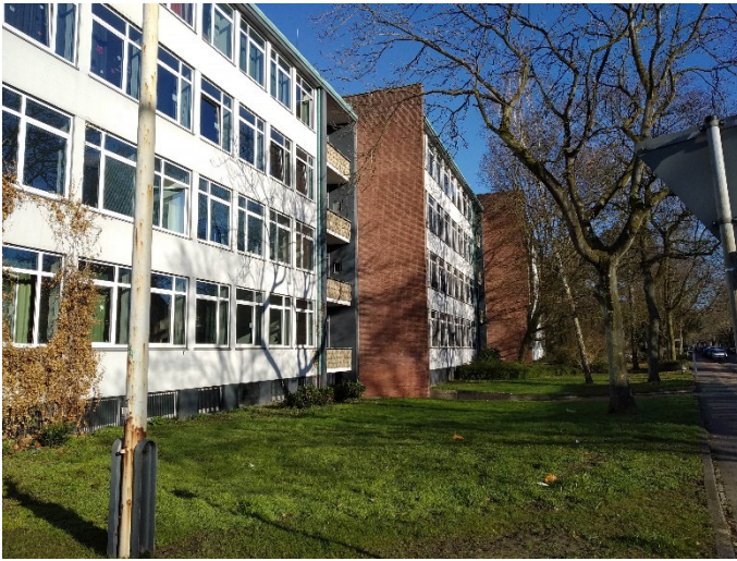
Abbildung 4 Schulgebäude, Ansicht Ost
