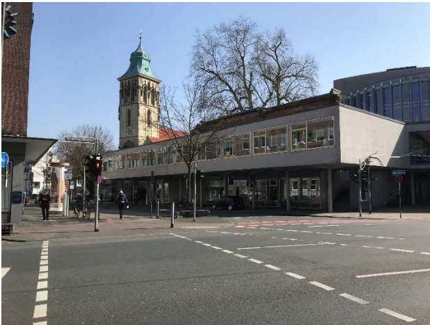
Abbildung 2 Ansicht Foyer, Großes Haus
