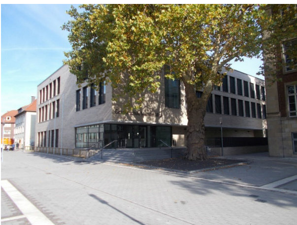
Abbildung 2 Schulgebäude Gesamtschule Münster Mitte
