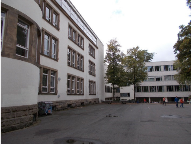
Abbildung 4 Altbau, Fachklassentrakt saniert
