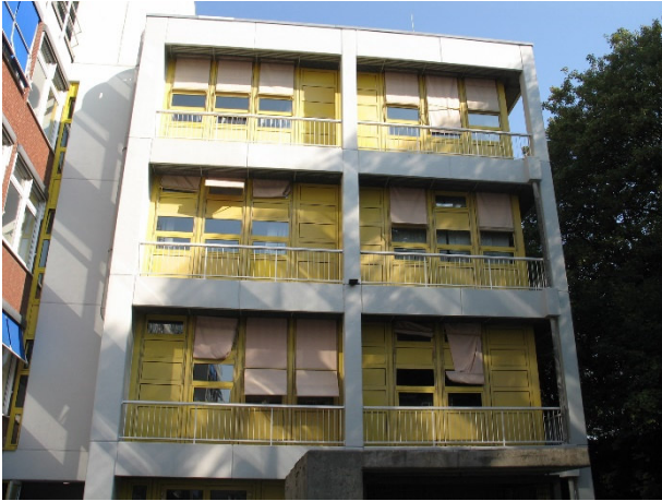
Abbildung 4 Schulgebäude Anbau, Rückansicht
