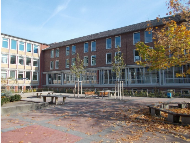
Abbildung 4 Schulgebäude ehem. Paul Gerhardt Schule
