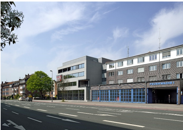
Abbildung 2 Ansicht Feuer- und Rettungswache 1, Erweiterung Leitstelle
