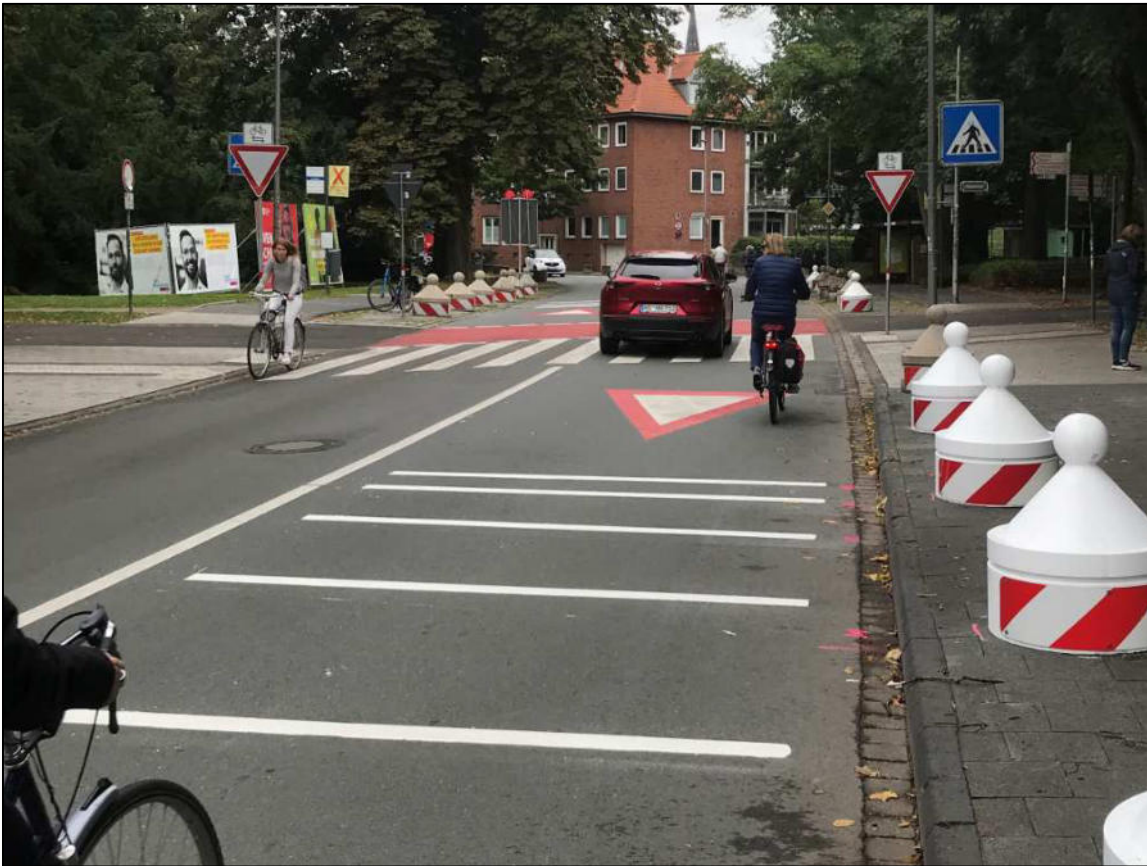
Abb. 4: Nachträglich aufgebrachte „Rüttelstreifen“ zur Aufmerksamkeitssteigerung (Stadt Münster)
