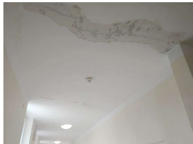
Abbildung 5 Innenansicht Wasserschaden
