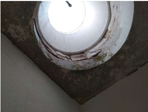
Abbildung 8 Wasserschaden Oberlicht
