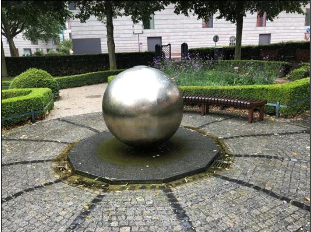
Abb. 1 Kugelbrunnen aus Edelstahl mit zentralen Auslauf auf einer Natursteinplatte und umlaufender Rücklaufrinne – Koordinaten 51°57'38.4"N 7°37'50.2"E
