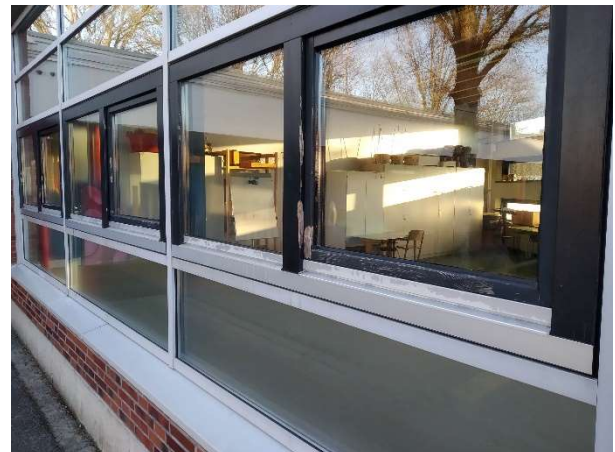
Abbildung 9 Beschädigte Holz-Fensterrahmen
