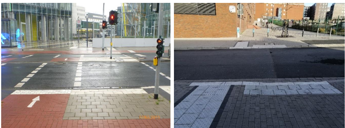
Abbildung 9: Beispiele differenzierter Bordhöhe mit Nullabsenkung und Hochbord
