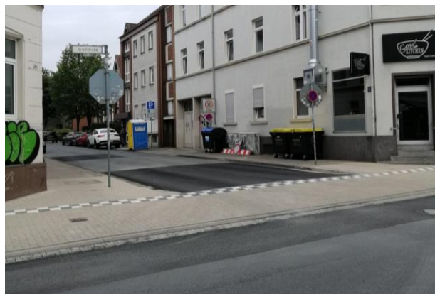
Abbildung 27: Beispiel einer Gehwegüberfahrt
