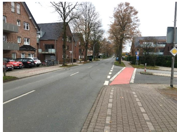
Abbildung 19: Fehlende sichere Querungsanlage auf der Havixbecker Straße
