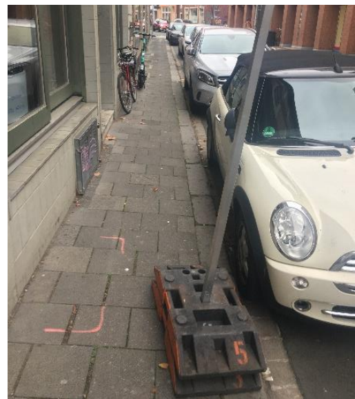
Abbildung 6: Baustellenbeschilderung auf dem Gehweg der Hörsterstraße
