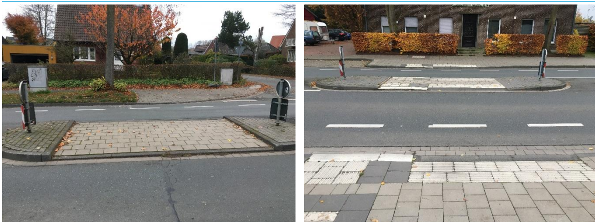
Abbildung 10: Querungshilfe ohne (links) und mit barrierefreier Ausstattung (rechts) auf der Pienersallee
