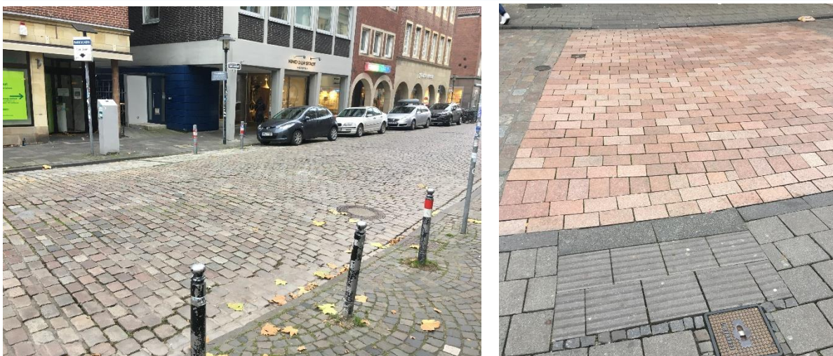
Abbildung 12: Fehlendes Querungsangebot am Spiekerhof (links) und barrierefreies Querungsangebot am Alten Steinweg (rechts)
