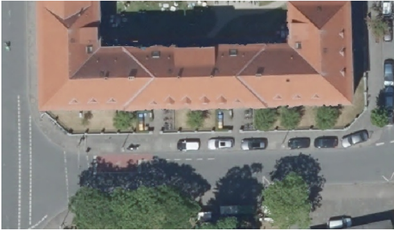
Beispiel Gehweg vor Haus Nr. 86/88
