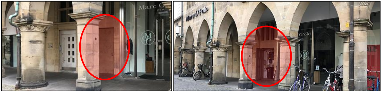
Abb. 45+ 46 Schalt- und Steueranlage im PVC Freiluftschrank im Gebäude
