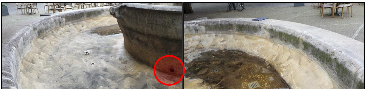
Abb. 21 + 22 Ablaufleitung der oberen brunnenschale in das untere Becken | Beckenrand unteres Brunnenbecken
