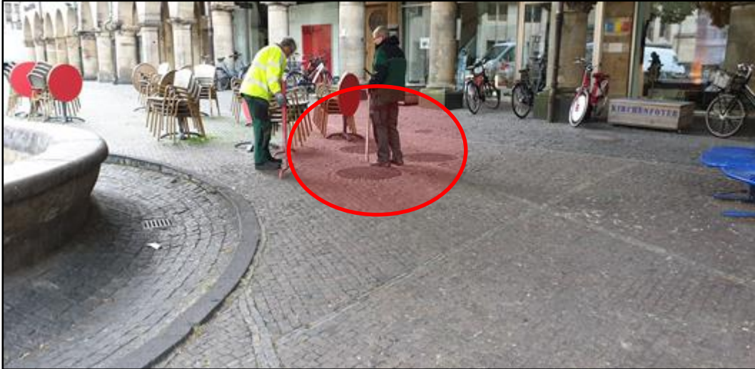
Abb. 31 | 1 Stück Unterflurbauwerk (li 2,0 x 2,20 x 1,75m) mit 3 Kammern | 1 Kammer Installationsschacht mit geschlossener Wand zum Pumpenschacht mit Trinkwasserinstallation und Durchführung der Druckrohrleitung | 1 Pumpenschacht als Einlaufbauwerk mit Tauchwand aus Stahl und Aufstellung der Unterwasserumwälzpumpe, Frischwassernachspeisung, Überlaufarmatur und Ablaufstopfen – Anschluss an den Kanal DN150
