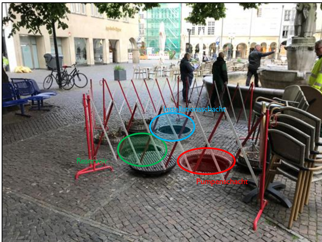
Abb. 32 | 1 Stück Unterflurbauwerk (li 2,0 x 2,20 x 1,75m) mit 3 Kammern
