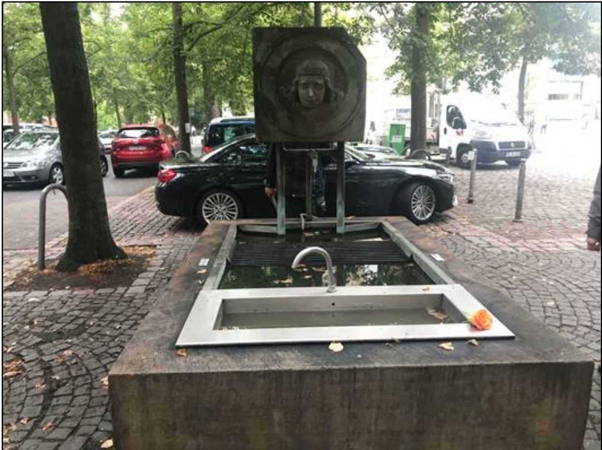
Abb. 1 Frischwasserbrunnen mit Kupferbecken und Edelstahlinsatz ; stehendes Wasser Koordinaten - 51°57'43.9"N 7°37'30.5"E
