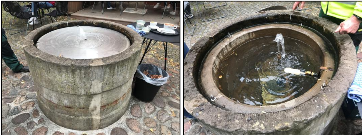
Abb. 1 Brunnen mit Edelstahlabdeckplatte und 1 Stück Quellauslauf - Koordinaten - 51°57'53.2"N 7°37'51.0"E
