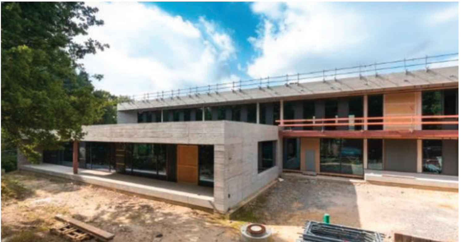
Abbildung 50: Grundschulneubau Kinderhaus - Im Bau (Quelle: https://www.stadt-muenster.de/immobilien/bauen/bauprojekte/grundschule-schulzentrum-kinderhaus )
