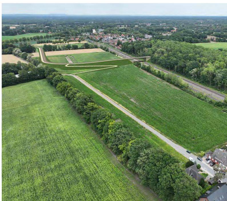
Brücke über die Bahngleise der Variante 1b (Blick in Richtung Sudmühle/Handorf)
