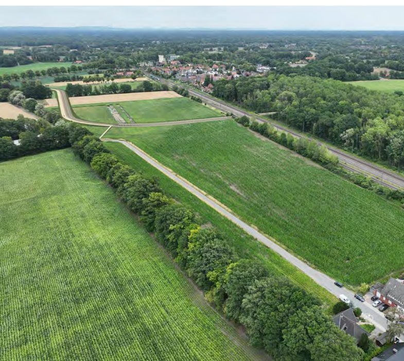
Straßenunterführung der Variante 1a (Blick in Richtung Sudmühle/Handorf)
