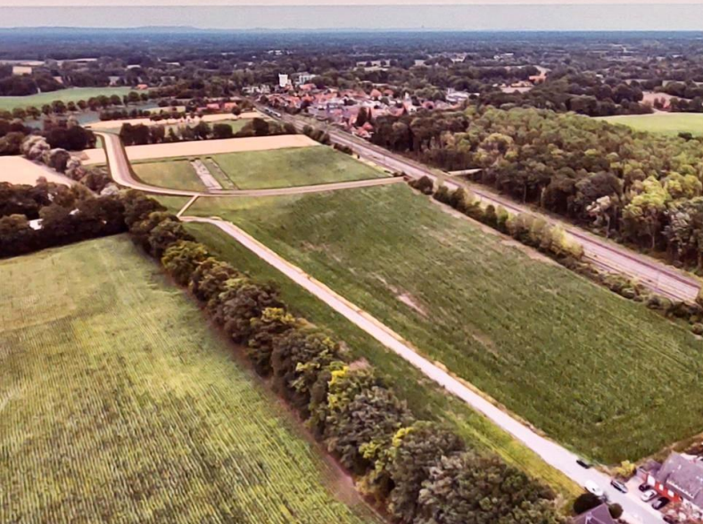
Straßenunterführung der Variante 1a (Blick in Richtung Sudmühle/Handorf)
