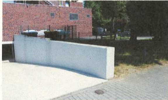
Abb. 7: Tiefgaragenzufahrt im Westen
