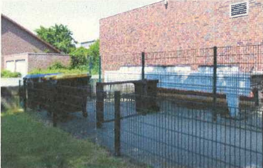
Abb. 6: Müllplatz und Klimaanlage im Norden
