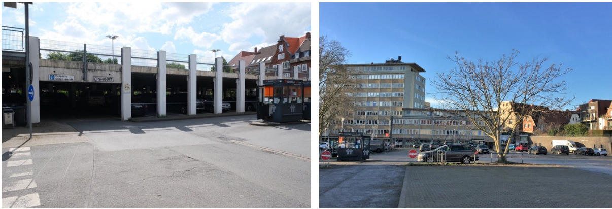
Abb. 44: links: Parkpalette Georgskommende (Foto: scheuven + wachten plus); rechts: Hörster Parkplatz (Foto: Stadt Münster)
