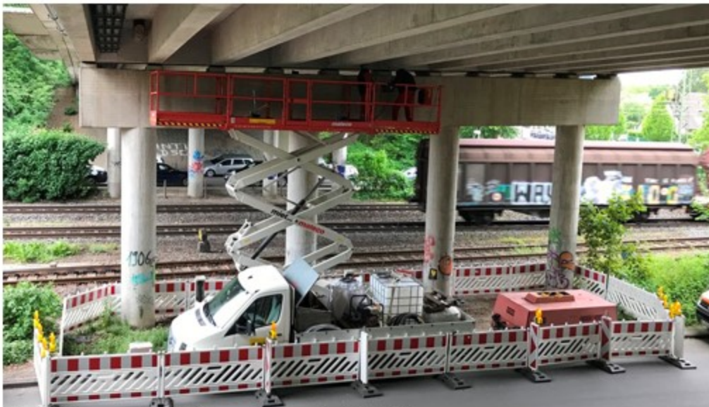
Durchführung der Probesanierung in 05/2019
