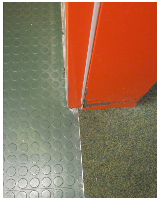
Bodenbelagsübergang Noppenfußboden u. Teppichboden
