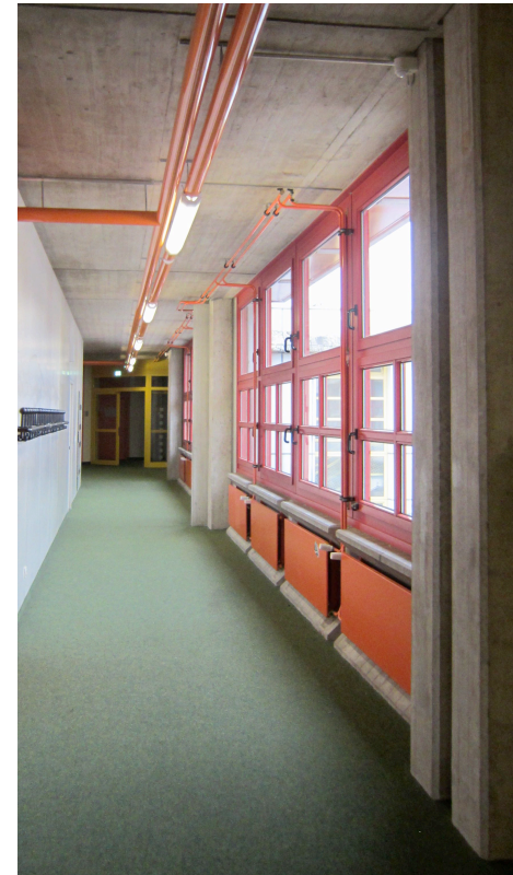
Sichtbetonsockel, Heizkörpernischen
