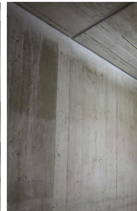
Sichtbetonwand und -decke
