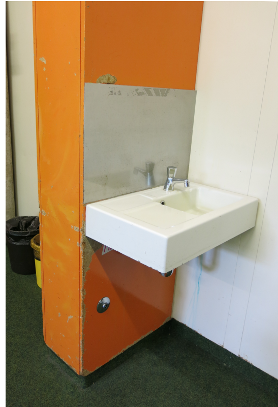
Wandpfeiler Waschbecken Klassenraum nach Farbleitsystem
