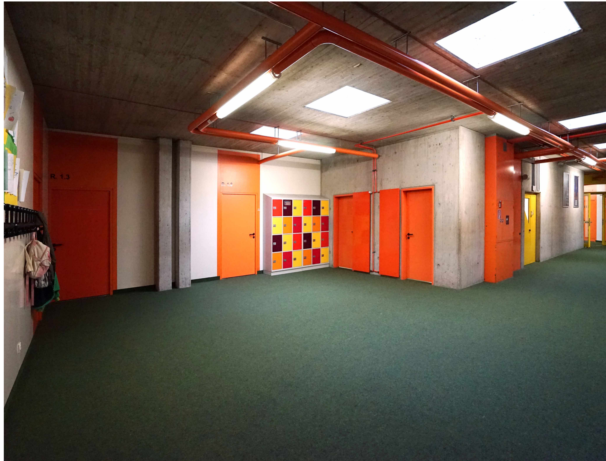
Vorhersituation Flur Klassentrakt
