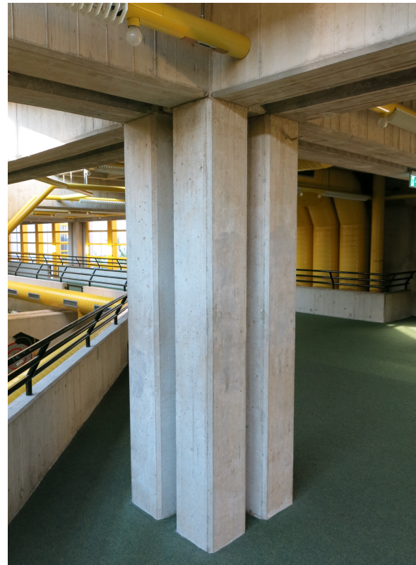
Sichtbetonstützen
