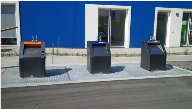
Abbildung 7: Abfallsammlung mit Unterflurcontainern an einem Studentenwohnheim
