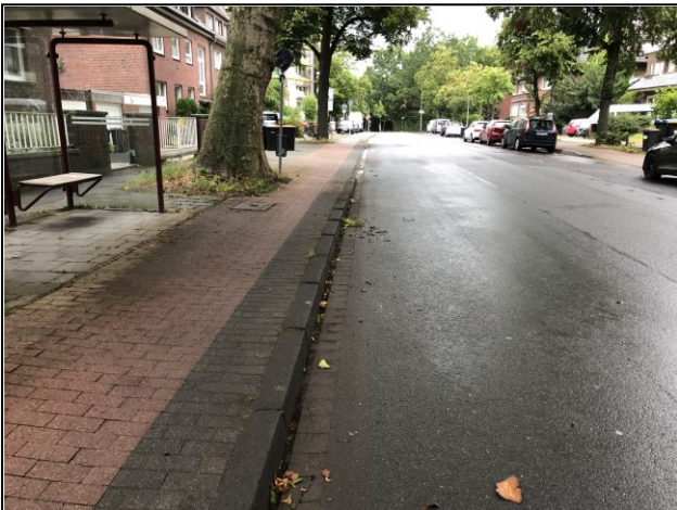
Abb. 4: Bestandssituation- Engstelle im Radweg
