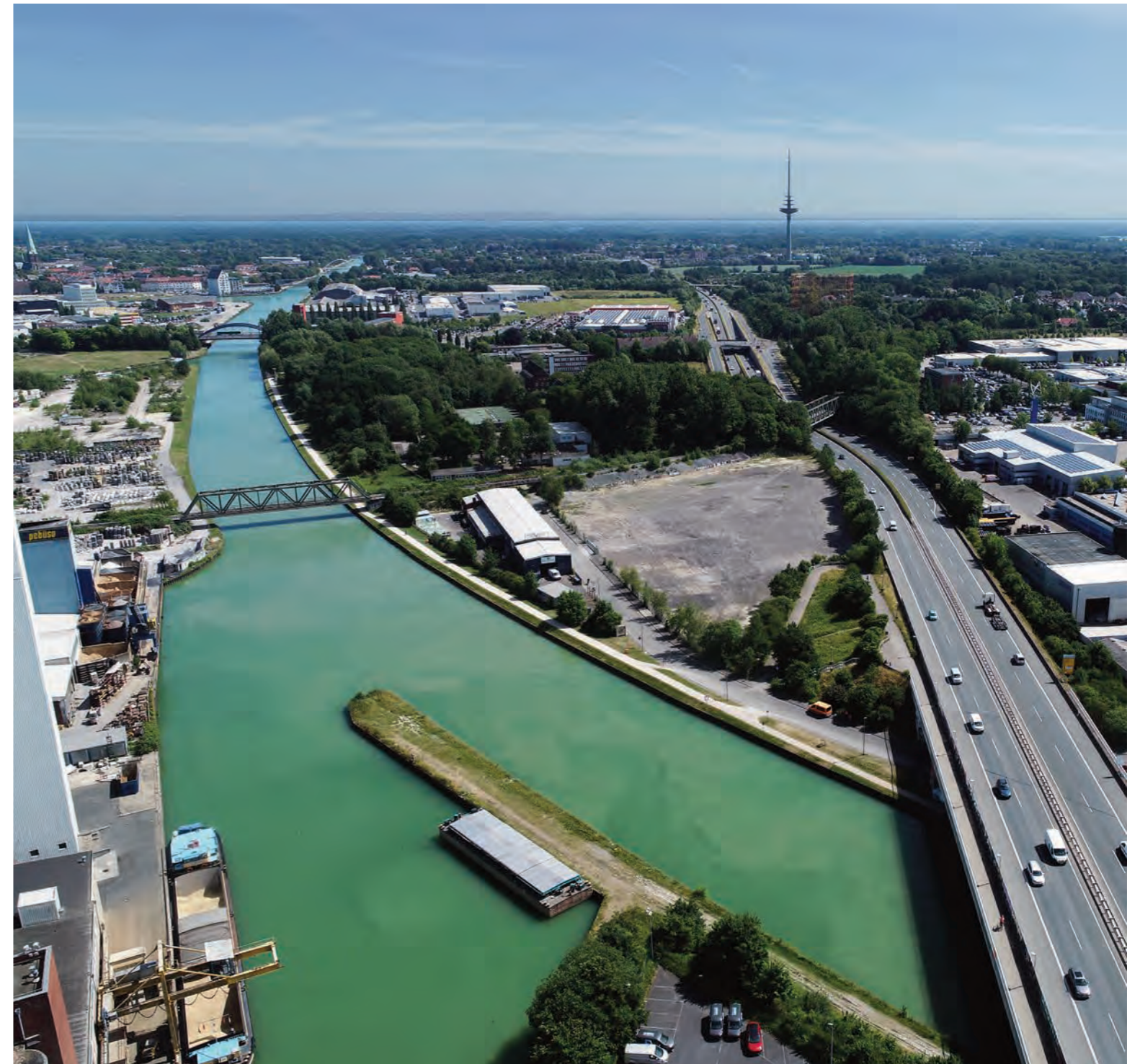
Brückenverbindungen und die Barriere der Bundesstraße
