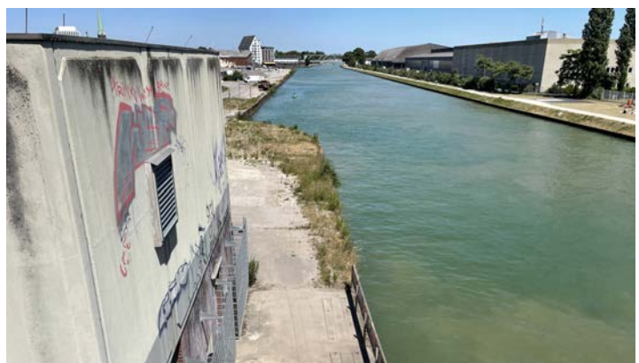
Stadtwerke-Entnahmebauwerk gegenüber der Feuerwache 2
